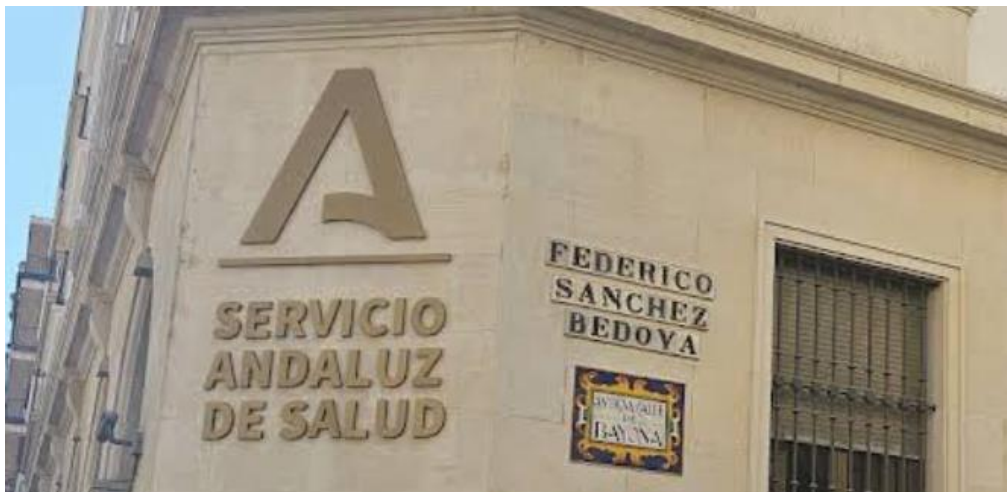
Figura 1. Edificio Servicio Andaluz de Salud. Fuente: Google Maps.
